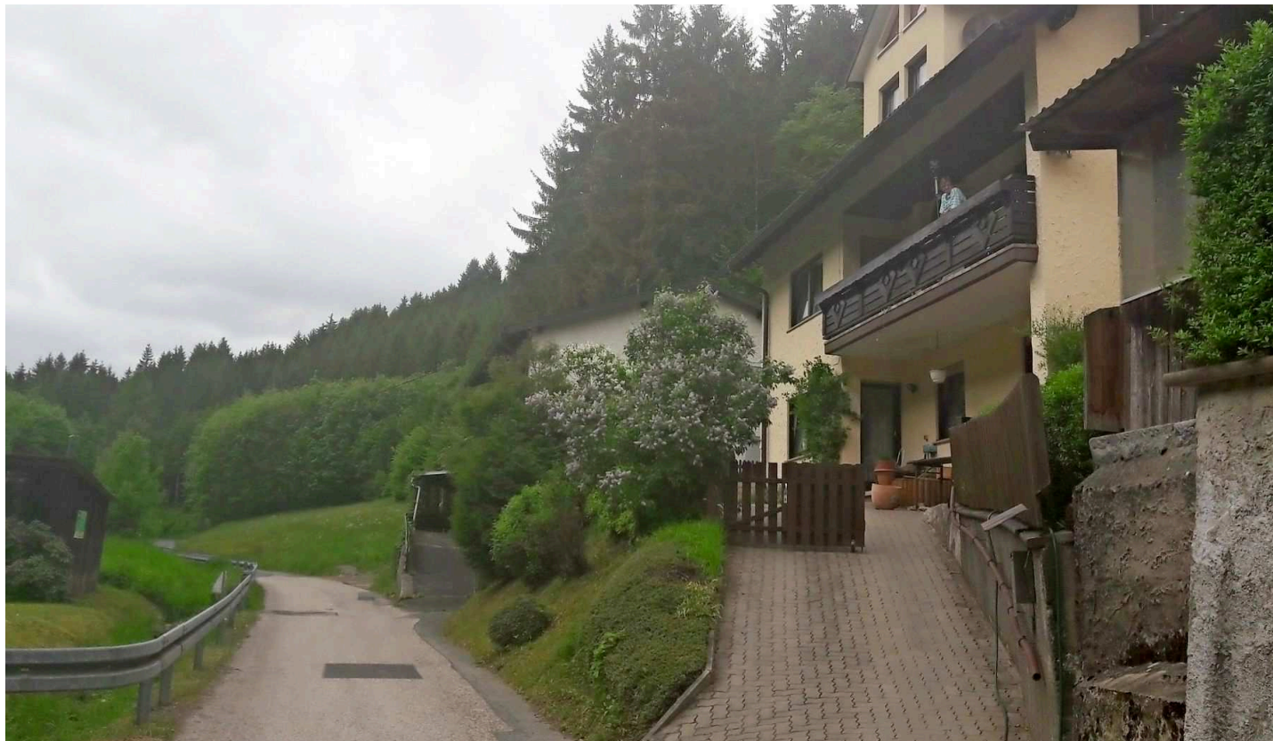
Weil sein Haus (rechts) an die Grieser Straße angrenzt, soll Harry Barras für deren Ausbau 20 000 Euro bezahlen.
